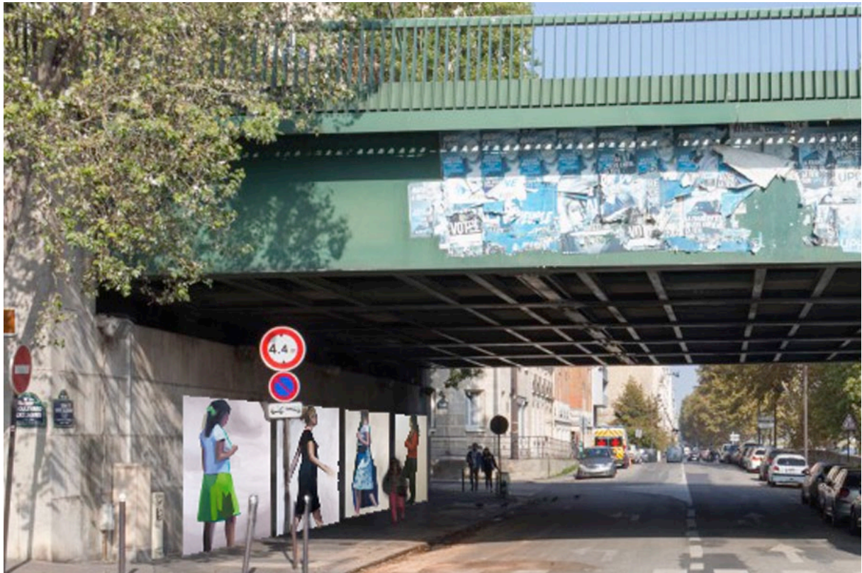
Passage sous le pont du Garigliano - Pont du Garigliano, quai Louis Blériot, Paris 16 - 3 m de haut sur 35 de longueur
